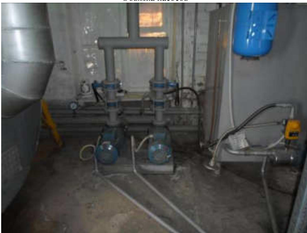
Видимое изображение №2 Обвязка насосов
