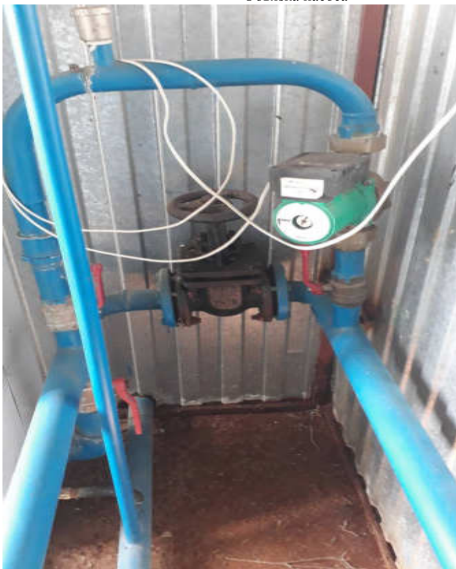
Видимое изображение №2 Обвязка насоса
